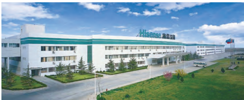
Hisense (Shandong) Air Conditioner Ltd., г. Циндао
